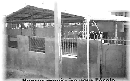
Hangar provisoire pour l'école
