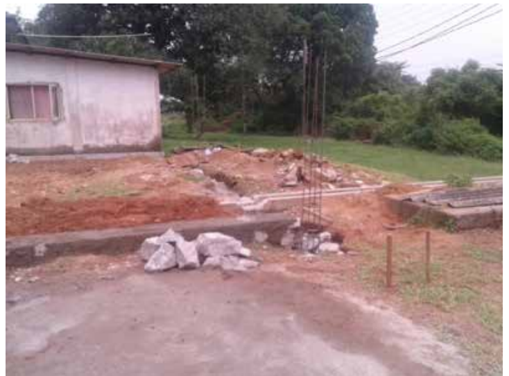
Construction en cours... (Photos prises le 05.11.2019) - fondation et colonnes en béton.
