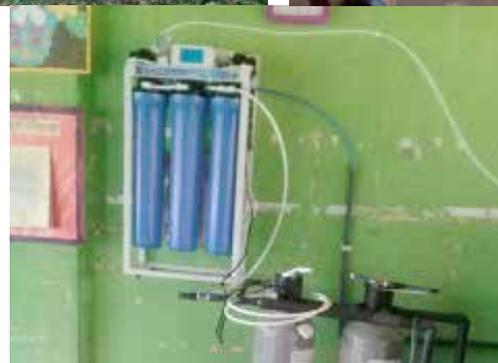
*Installation de la pompe et du système de filtres dans la petite école d'UTTIMADUWA*
