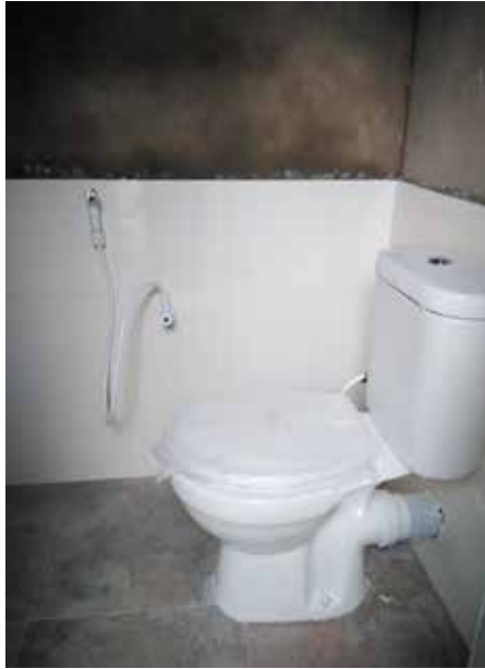
Les nouvelles toilettes
